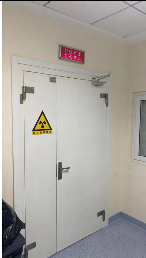
患者出入口设置的放射性标志、中文警示说明和 “射线有害 灯亮勿入”工作状态灯箱
