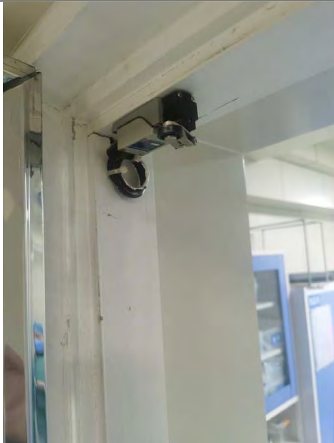
门灯联锁(患者防护门关闭警示灯自动亮起)
